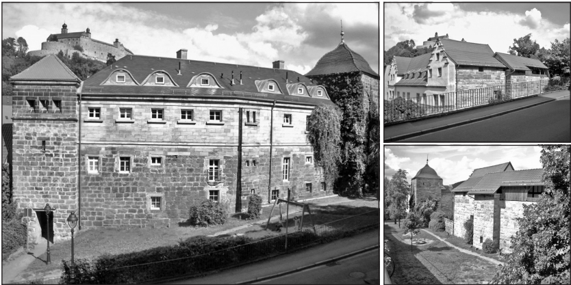
Burggüter der Waaggasse als Teil der Kulmbacher Stadtbefestigung
